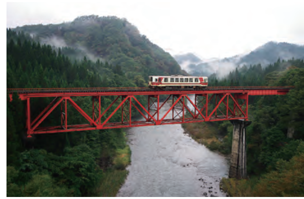
第4景 大又川橋梁（萱草～笑内） 沿線一の絶景ポイント。まるで空中遊泳。
