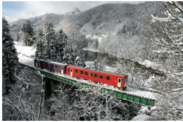
第3景 荒瀬川橋梁（阿仁合～荒瀬） ここから一段と山が深まり、渓谷が連続する。
