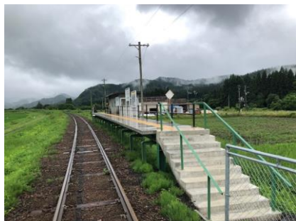
前田南駅ホーム改修工事
