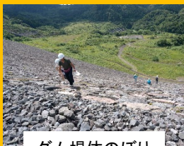
ダム堤体のぼり
